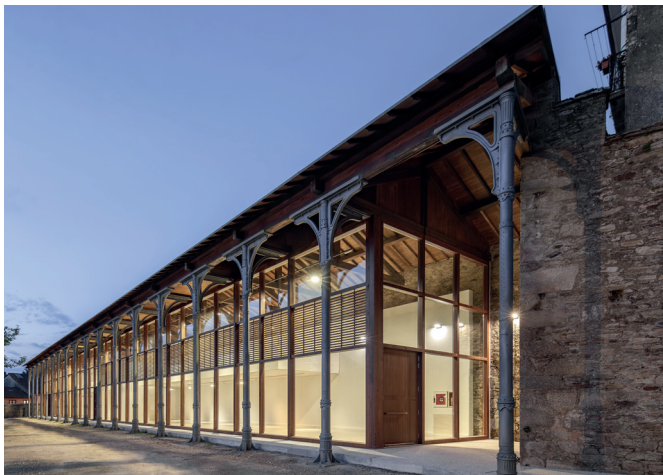
FOTO.- Rehabilitación do pavillón historicista do mosteiro de San Martiño Pinario (arquidiocese de Santiago)
