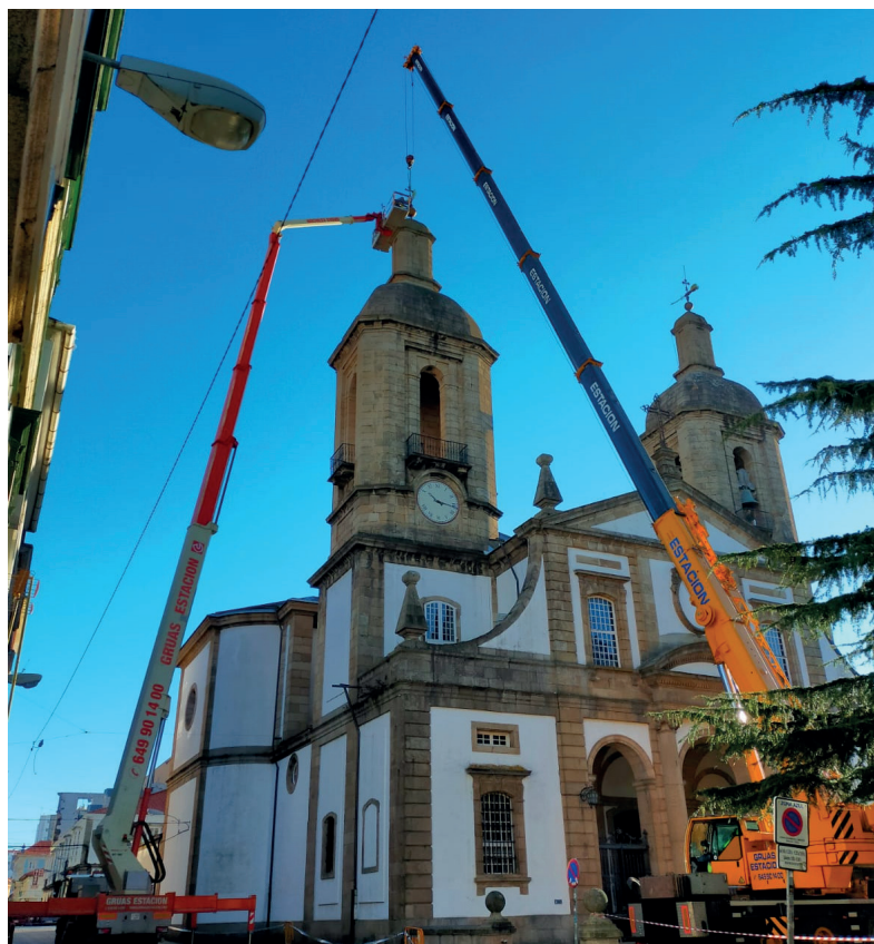
FOTO.- Rehabilitación da torre norte da Concatedral de San Xulián (diocese de Mondoñedo-Ferrol)
